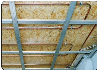
Die Kupferheizrohre wurden von der Decke abgehängt. Erforderlich ist ein Hohlraum vom mindestens 50 mm zur Aufnahme des Heizrohres mit den Aluminium-Wärmeverteilern.
