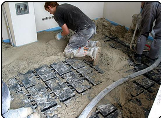
Im Gegensatz zu herkömmlichen Fußbodenheizungssystemen (= direkt in Estrich integrierte Heizrohre) ist bei der Janßen-Fußbodenheizung ein Funktionsheizen zur Vermeidung von Rissbildungen im Estrich/Oberboden nicht notwendig.
