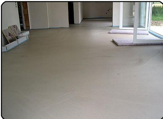
Ein Belegreifheizen kann nach Maßgabe der unten aufgeführten Tabelle durchgeführt werden. Die Tage sind vom Tag des Einbringens des Estrichs an gerechnet. Bitte beachten Sie:
